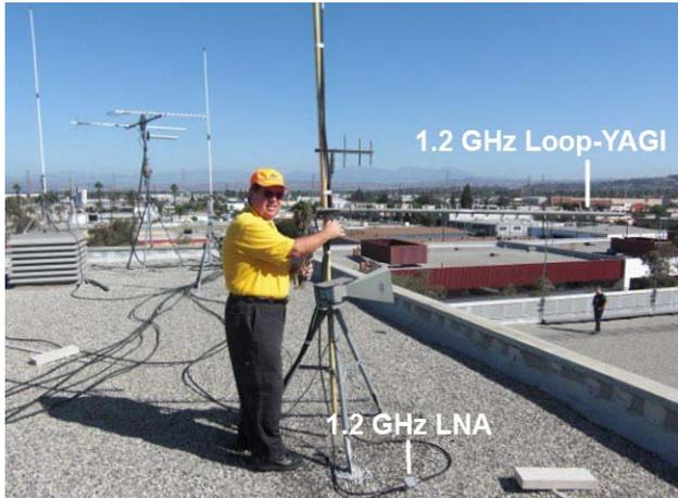
**Bild 3 – Robbie (KB6CJZ) richtet die Empfangs-Loop-Yagi-Antenne aus**
